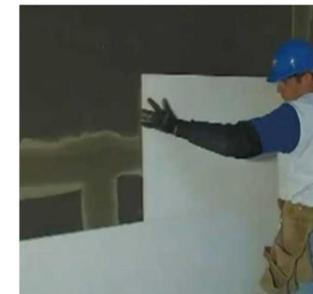
Fijación al sustrato por medio de arandelas plásticas y tornillo de forro TFR punta de broca según espesor de EPS y panel de sustrato. El panel EPS o XPS deberá recibir por lo menos nueve arandelas por panel de 61cm. X 1.22m. (24"X48").
