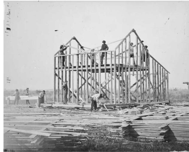
Construcción de Vivienda con sistema Balon Framing.
