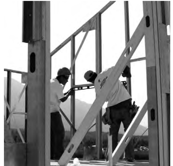
Unión de bastidores estructurales PANEL REY* con tornillos autoroscantes.
