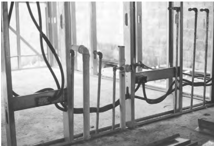
Perforaciones de fábrica en los componentes poste-viga PANEL REY* . En caso de requerirse mayor dimensión en las perforaciones, hacerlas de acuerdo a las especificaciones de la tabla V-05.
