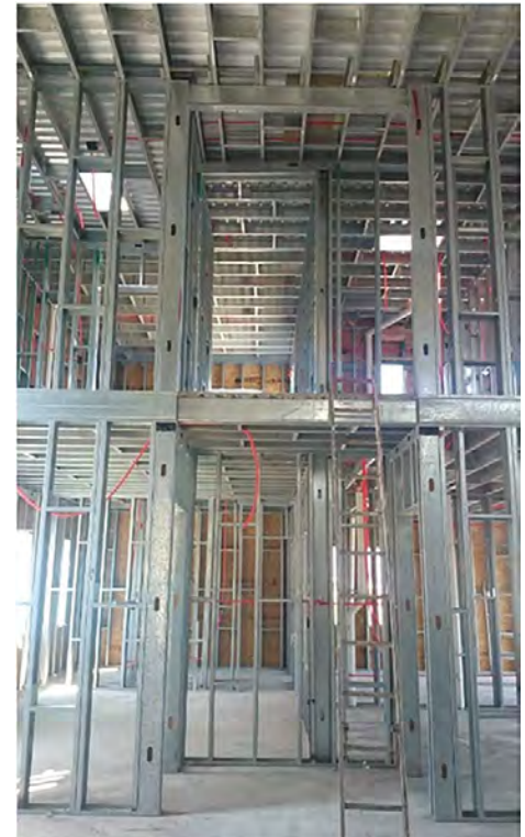
Dintel sobre puerta de acceso.
