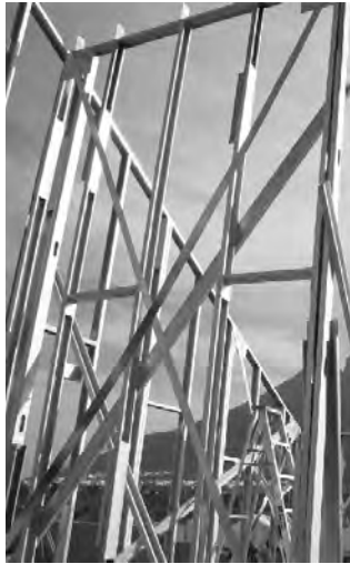
Figura 1.5 Sujeción lateral continua a los tercios.
