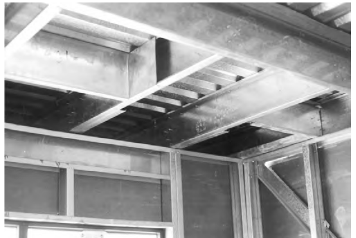
Postes-vigas PANEL REY* actuando como vigas de entrespiso, arriostradas con bloques sólidos.
