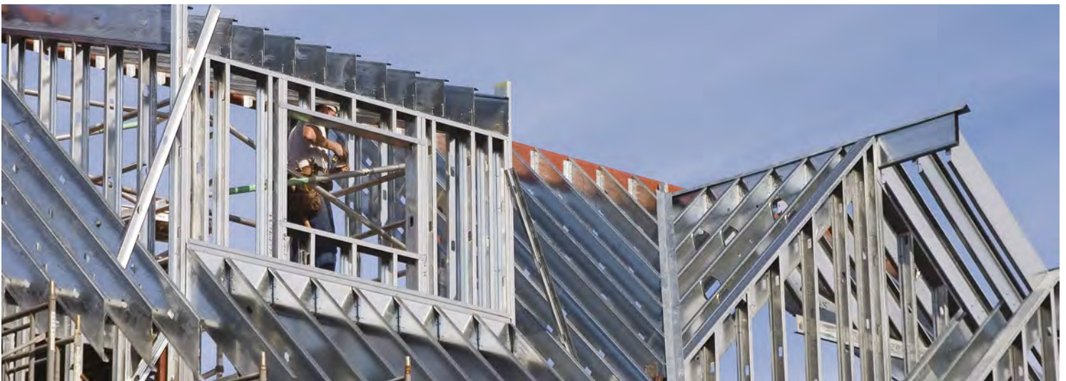
Construcción de casa habitación
