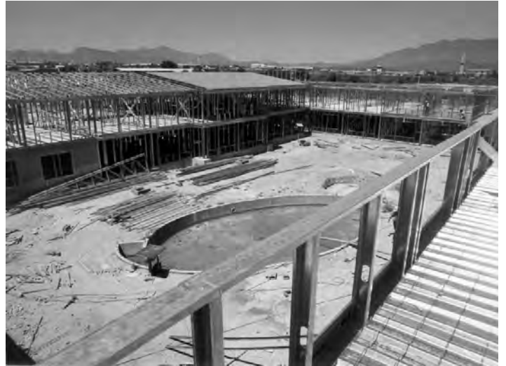
Hotel Fiesta Inn Saltillo en proceso de construcción.
