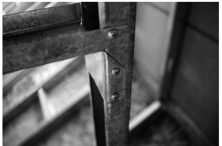
Tornillos estructurales de cabeza extraplana TXP-12 uniendo a postes-vigas de bastidor de carga PANEL REY*.
