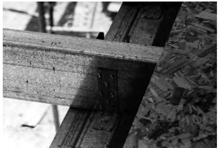
Tornillos estructurales de cabeza hexagonal THX-34 uniendo postes-vigas PANEL REY* de entripiso.
