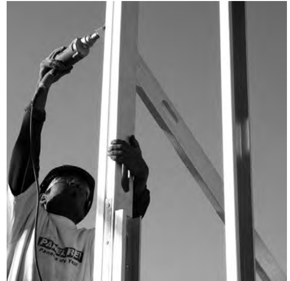
Colocación y fijación de tornillos estructurales autoroscantes de dintel sobre ventana.
